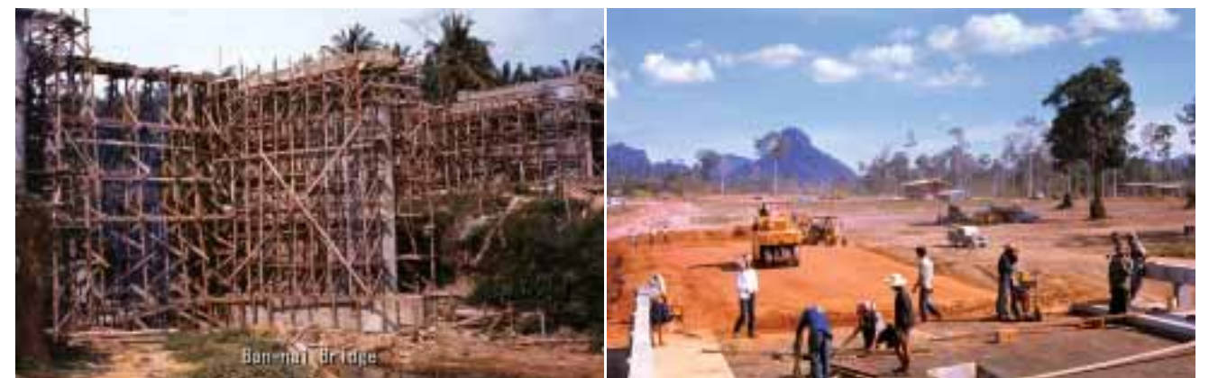
写真3、4—東南アジア(タイ)における橋と道路の建設(1970年代初頭)
