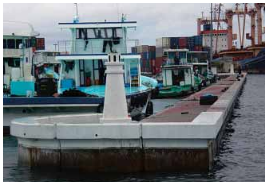
写真1—モルディブの防波堤
