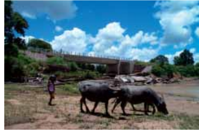
■写真7—ラオス国道13号線橋梁架け替え(50橋)
