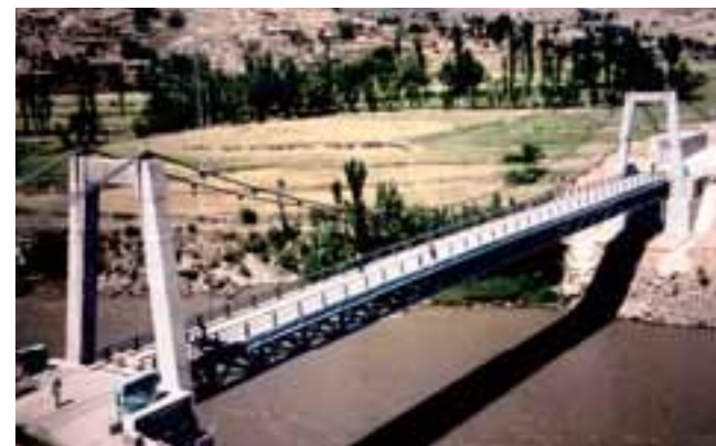
■写真3—パキスタン国北西辺境州の地方橋梁(20橋)
