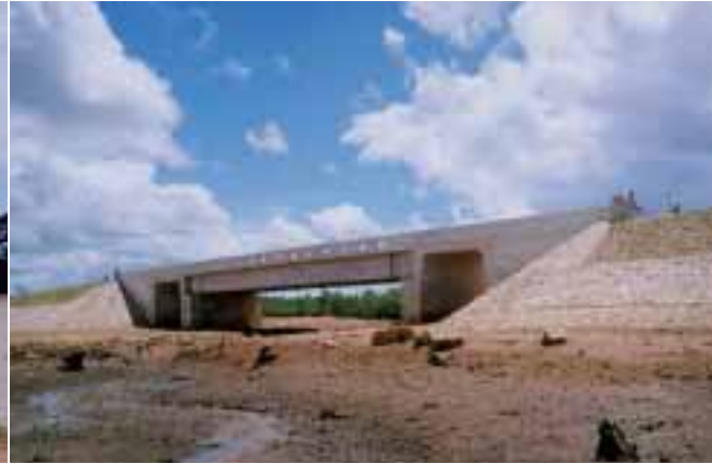
■写真6—タンザニア国ムトワラ橋梁架け替え(5橋)
