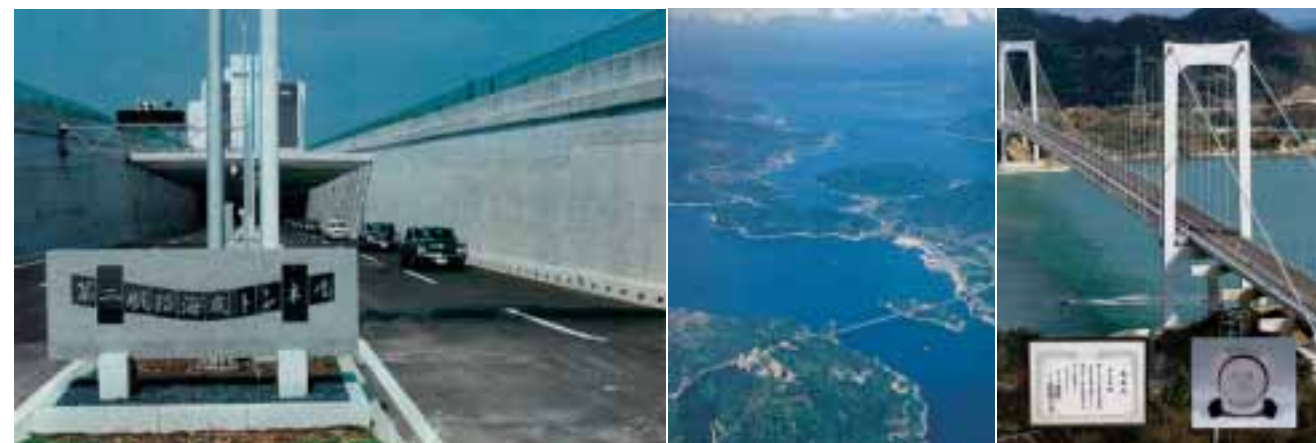
■写真1—東京港第2航路トンネル道路。延長744mの沈埋トンネル(124m×28.4m×8.8m×6函) ■写真2—大島大橋(橋長840m、中央径間560m)
