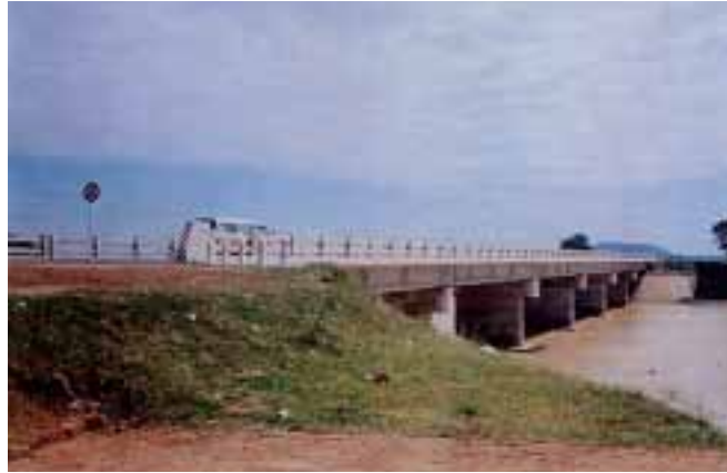
■写真5—カンボディア国道6・7号改修(道路延長73km、橋梁10橋)
