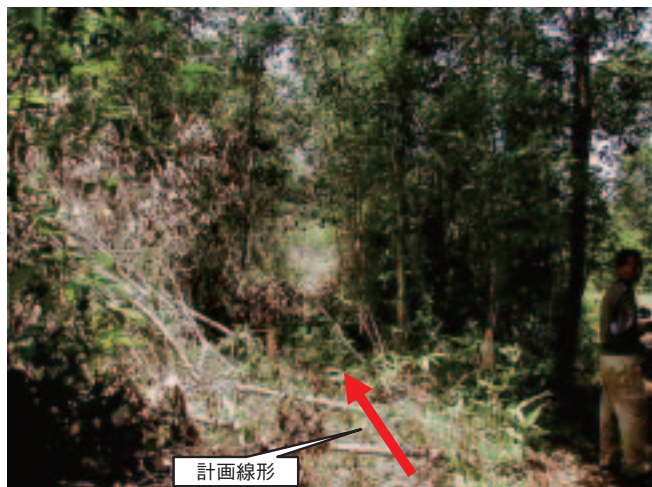
■写真4—道路新設区間
