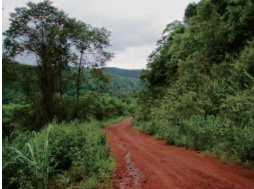
■写真3—国道16A号既設道路区間
