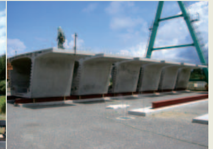
■写真4ーセグメント置き場
