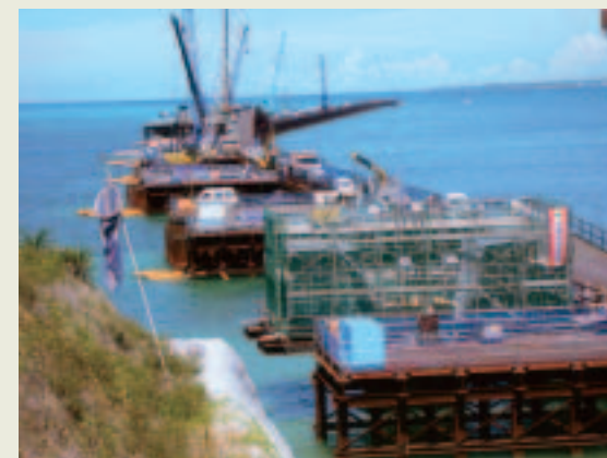
■写真5、6ー架橋地点の工事状況(7月時点)
