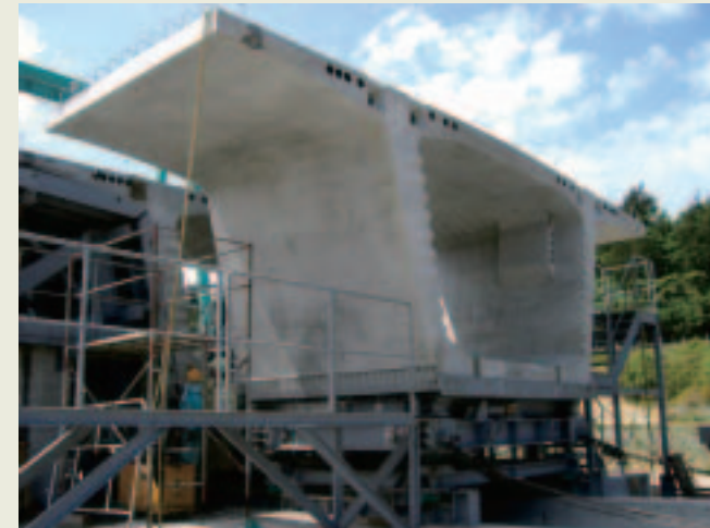
■写真3ーセグメント製作台
