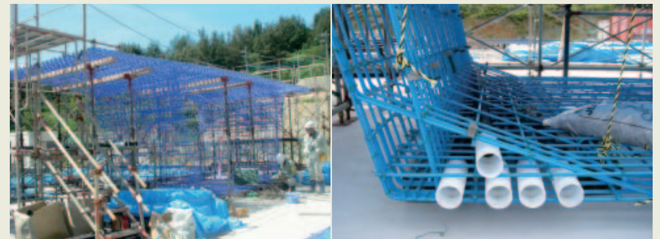
■写真1、2—エポキシ被覆鉄筋の使用
