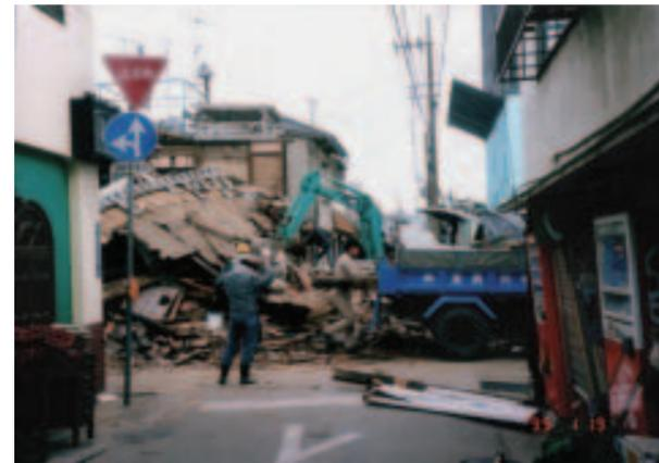
■写真2—復旧の手始めは道路に倒壊した建物の撤去
