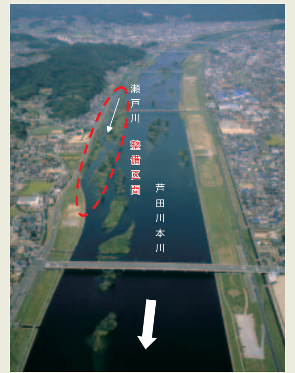
■写真1—整備区間(芦田川右岸:距離標5K700~7K000)
