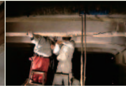
写真3—亀裂発生箇所の様子
