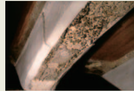
写真2—桁下面の橋軸方向ひび割れ
