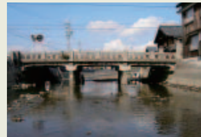
写真1—内海橋の様子(対策実施前、下流側から望む)
