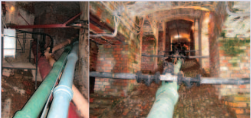
■写真11（左）—赤いパイプは大滝へ水を送る。色分けは噴水師が文字の読めない労働者に指示を出すためのもの。パイプは太いもので直径約60cm、その他のメインパイプは直径30~40cm ■写真12（右）—宮殿の下には配管のために広い空間が確保されており、太いパイプから細いパイプが枝別れしていく
