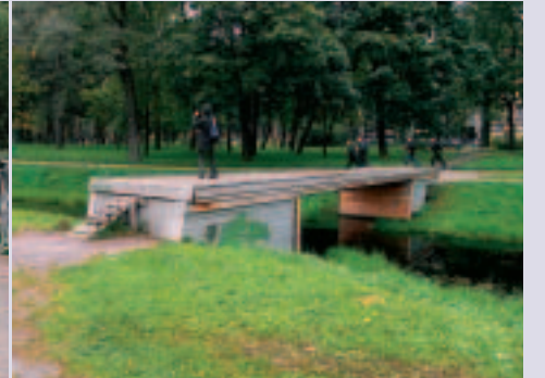
■写真10—同じ水路に架かる木橋
