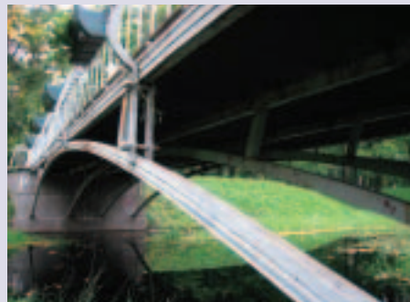
■写真6—「西の橋」の床下
