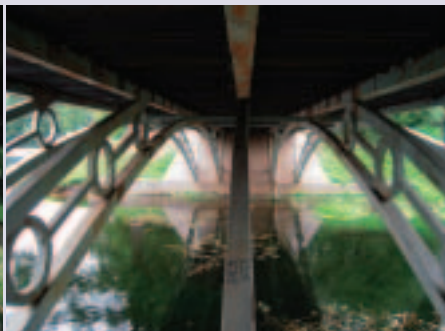
■写真7—「北の橋」の床下
