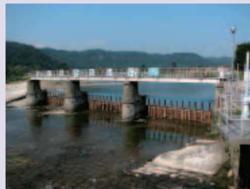
■写真1—多摩川の羽村取水堰
