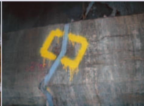
■写真8—扶壁にできた「ひび割れ」の補修跡
