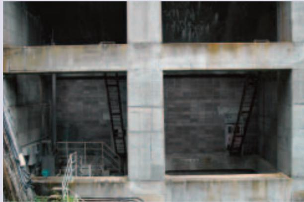
■写真5—扶壁の内側に見えるブロック積みの保温壁
