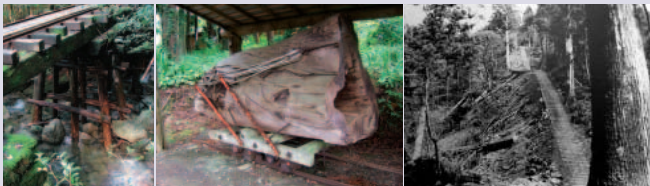
■写真6 沢に架かる木橋
