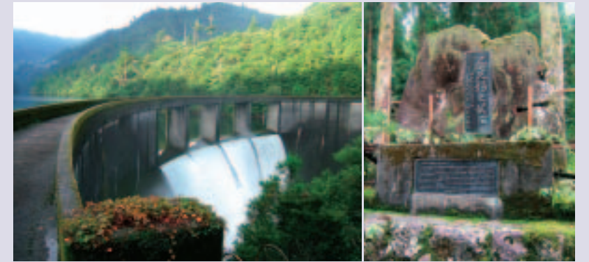
■写真9 屋久島の水力発電を担う尾立ダム（荒川ダム）
