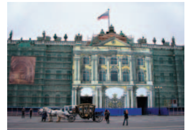
■写真8—宮殿広場に面した「冬宮」のファサード(補修中)
