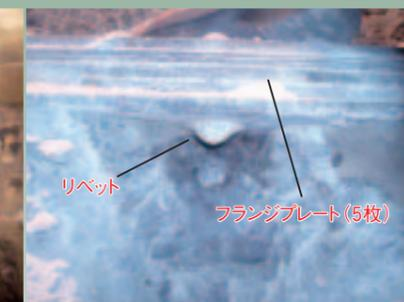
写真2 鉄骨の状況確認(上フランジ側面)
