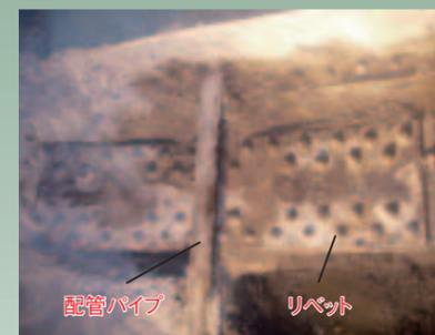
写真1 鉄骨の状況確認(フランジ上面)
