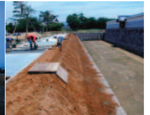
写真6 内堀の法面に投光器入ボックスを埋設
