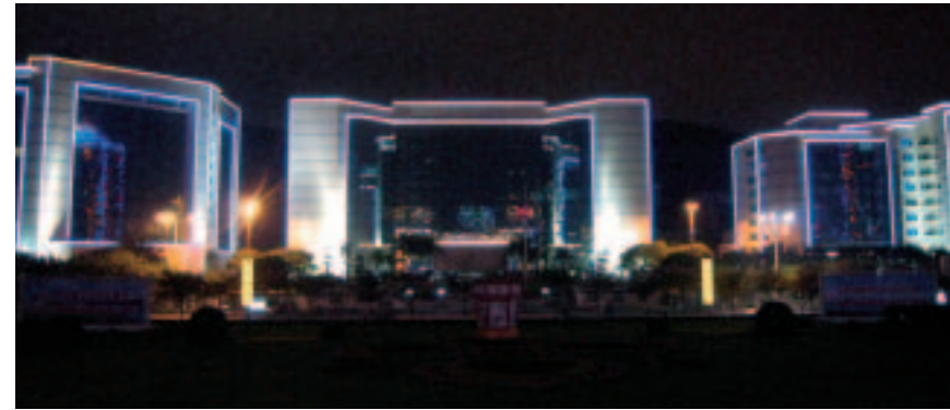
写真10 アモイ市のLEDによる景観照明
