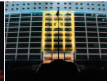
写真12 槐蔭区役所正面
