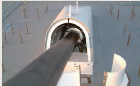
EMセンサーの設置状況(斜張橋ケーブルの張力管理)
