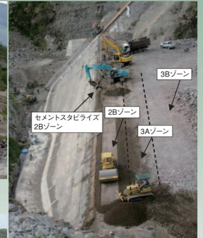
写真4 上流法面の施工(右岸から撮影)
