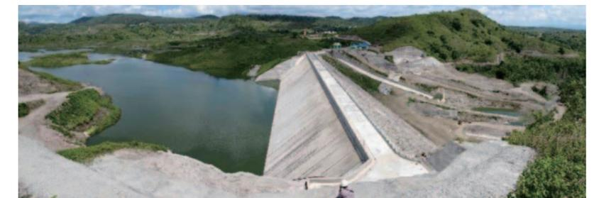
写真6 試験湛水中のダムと貯水池
