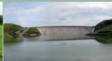
写真2 試験湛水中のダム
