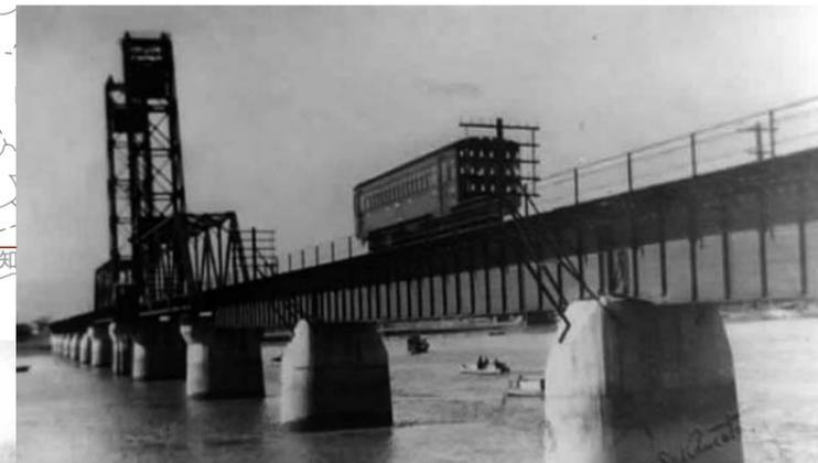
② (上) 筑後川昇開橋は昭和10年の旧国鉄佐賀線の敷設とともに架設された東洋一の可動鉄橋。筑後川の河口に位置し、大型船の往来も多いことから中央部の橋が上下に可動する構造となった
