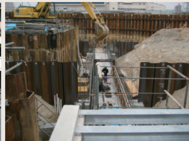
自らが設計した現場の確認
