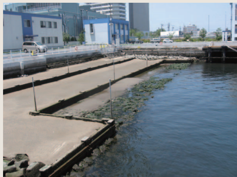
横浜港湾空港技術調査事務所前面に設置された実海域環境実験施設
