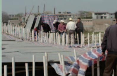
写真9 大量のパイプから水ガラスを注入して窯址を固化する作業
