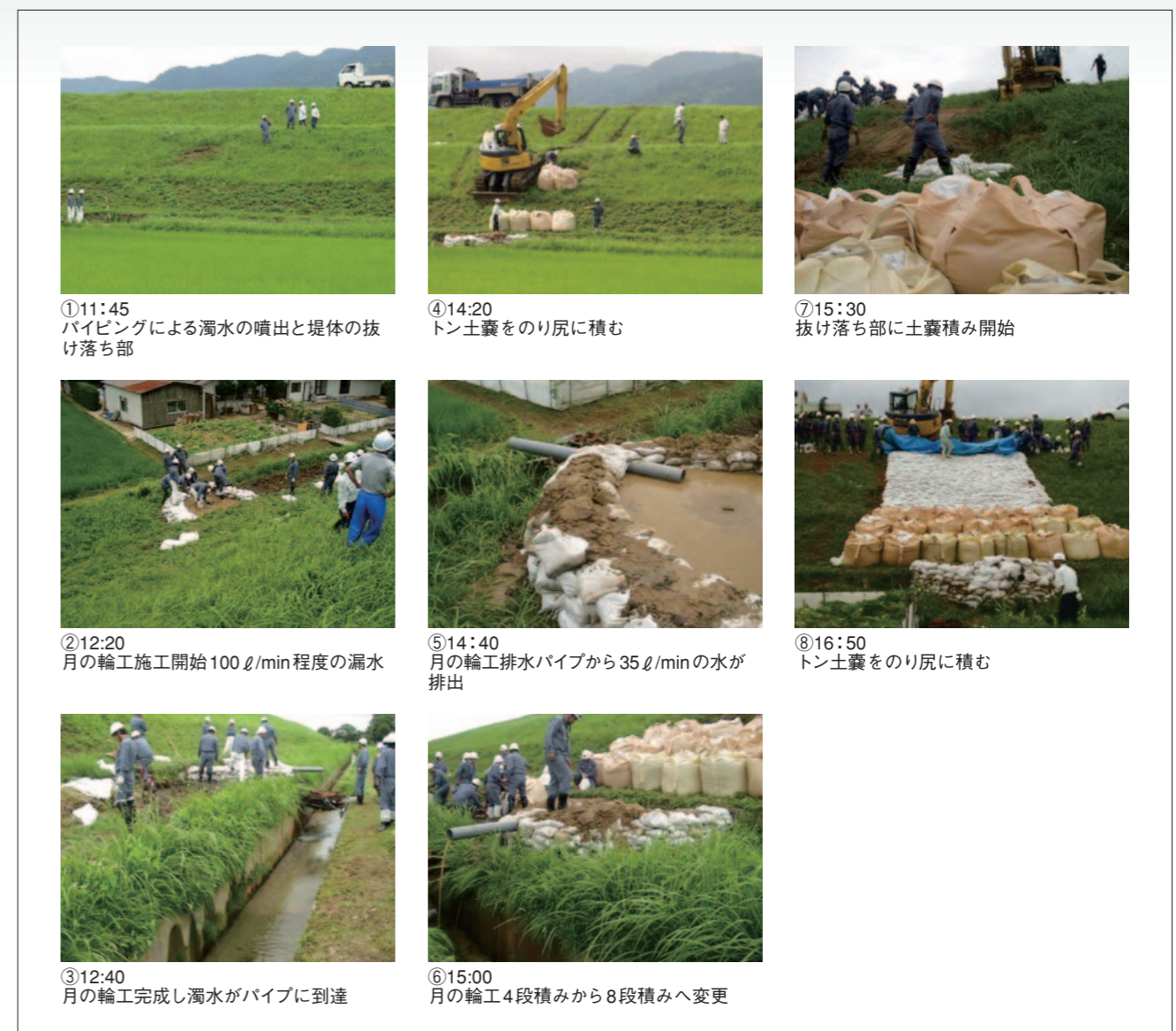
図3 変状の発生と水防活動の状況(7月19日)
