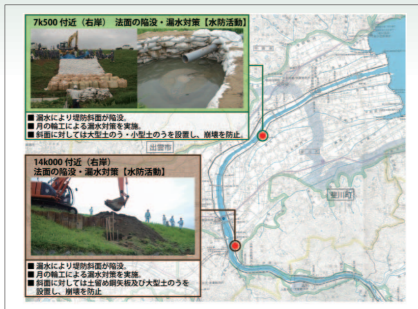
図1 平成18年7月豪雨時 斐伊川本川下流部のり面変状発生箇所
