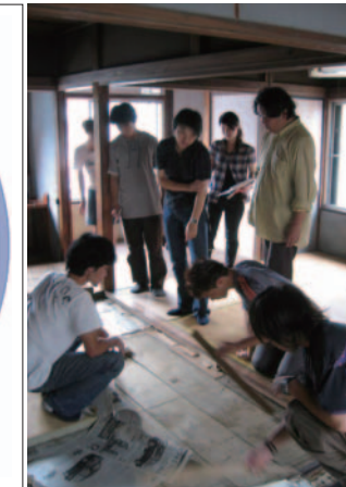
写真13 アートセンターに向けたリノベーション (池田修)
