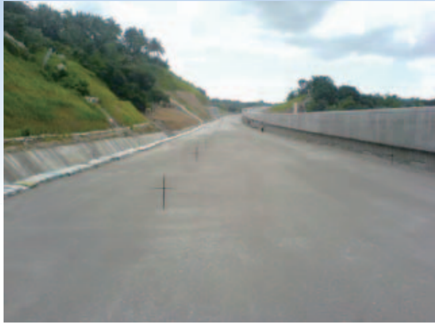
写真6 ラハールを用いた路盤
