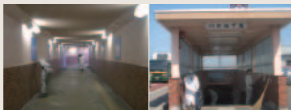
大曲バイパス地下道の清掃
