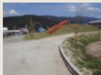
公園：庄内公園(工事中)
