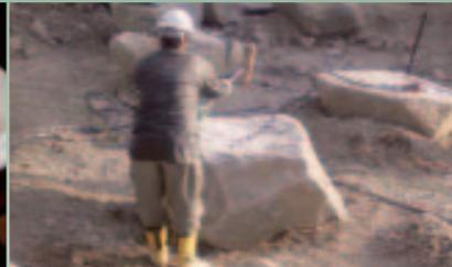
写真6 手作業による石割状況
