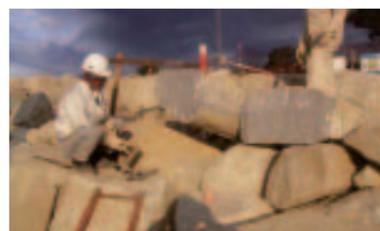
写真8 石積み状況 (荷重伝達点の確認)
