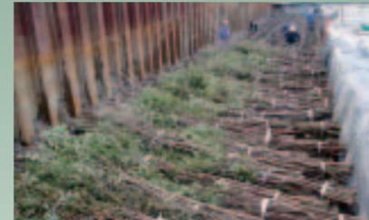
写真9 粗朶沈床
