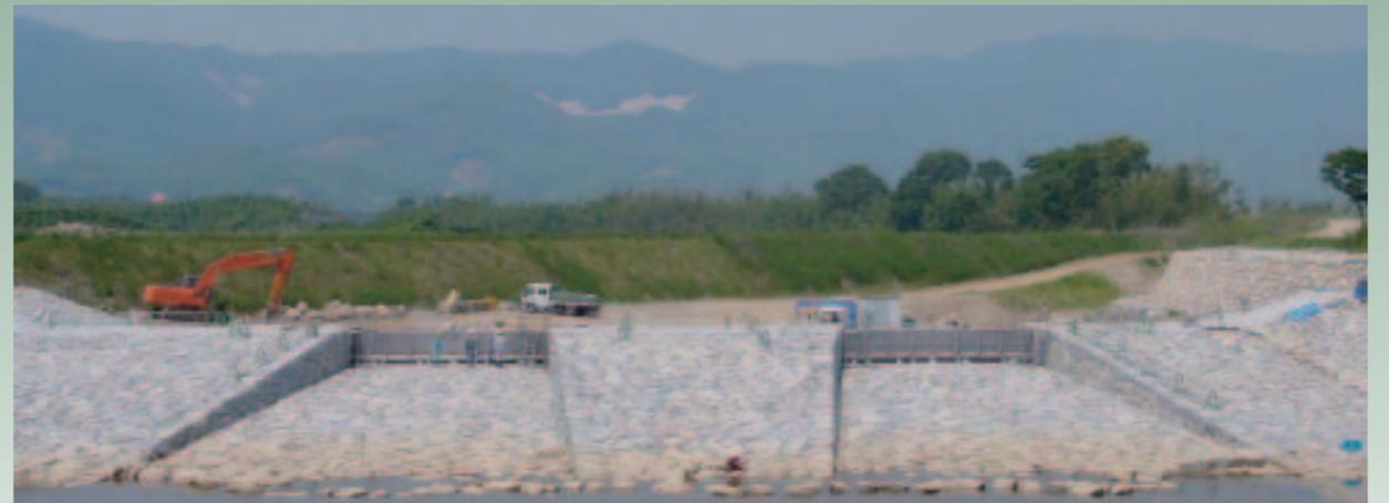
写真2 施工中の石井樋大井手堰全景(前方に見えるのは迂回路の護岸。本線切り直し時に撤去)
