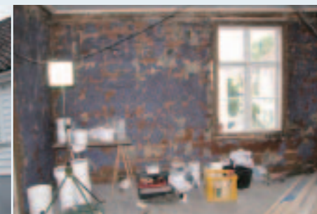
写真3 修復中の家の内部。建築当時の青い壁紙が残っていたため、保存すると共に、当時の壁紙を復元して使用する予定
