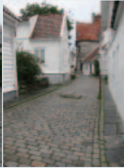
写真5 道の中央に車止めの石を設置し車両の通行を制限
