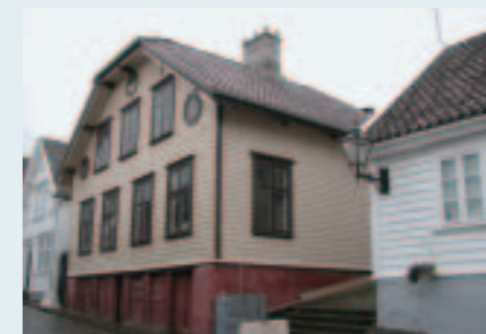
写真2 市がアドバイスをしながら進めている修復中の家
