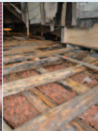
写真7 床下には瓦礫を敷き詰め丸木を組む
