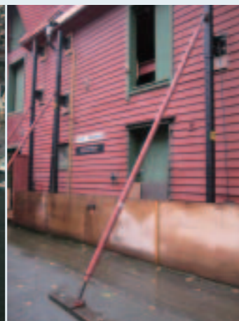
写真6 ジャッキアップされている修復中の建物
