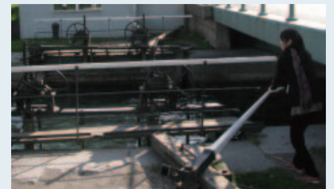
写真4 リングスボーにある女性の力でも操作可能な手動閘門
