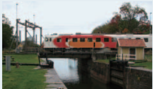
写真7 ノーシュホルムにある鉄道の片持ち式の跳ね橋
