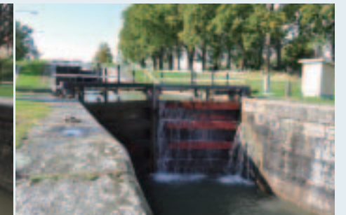
写真3 ベリにある鉄製になった門扉
