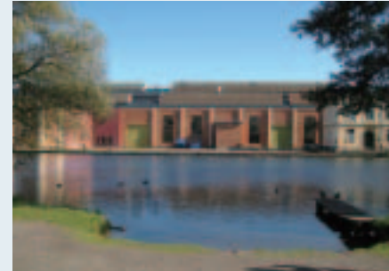
写真8 モータラの機械工場の建物
