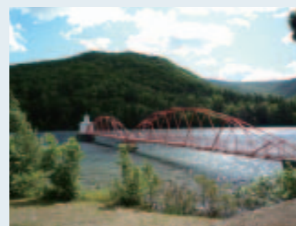
写真5 取水塔と連絡橋
