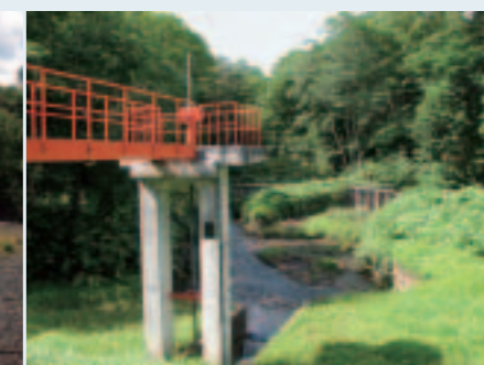
写真7 上流にある河川水の引き入れ部
