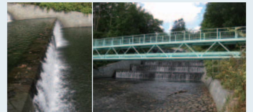
写真11 遮水壁に水が溜まって階段に見える 写真12 水階段と管理橋階段に見える
