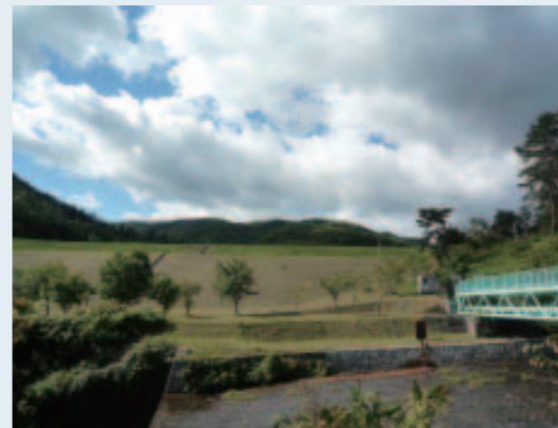
写真3 奥沢ダムの土堰堤
