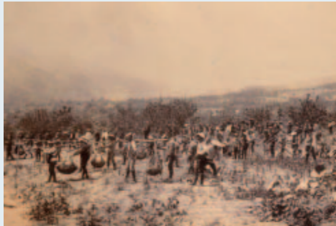
写真8 貯水池内掘削作業で働いた多くの人
