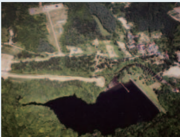
写真1 奥沢水源地水道施設
