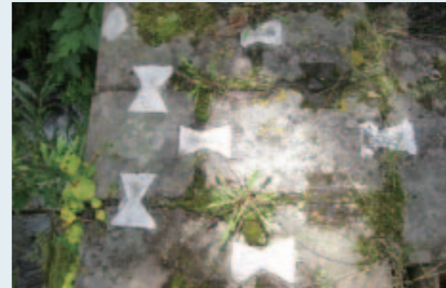
写真10 ずれないように石の接合に使われている溶鉛詰め
