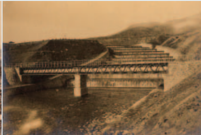
写真9 完成当時の溢流路と管理橋
