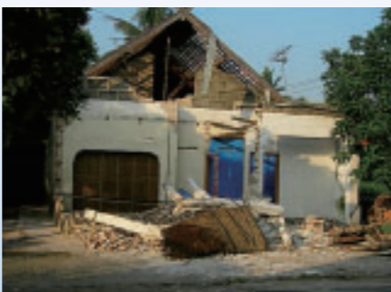
写真10 ジャワ島中部地震で被害を受けた家屋
