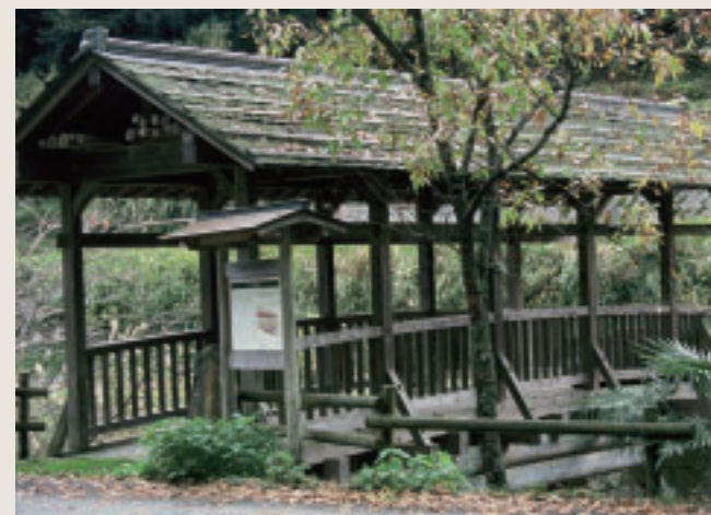
屋根付橋「下の宮橋」(歴史的建造物の復元)
