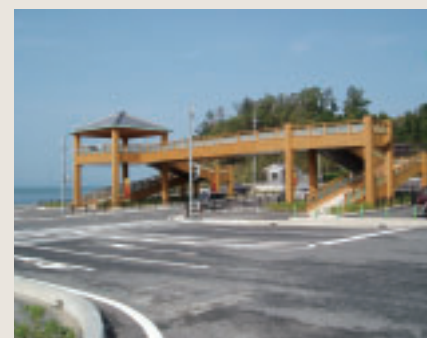
国道196号大浦横断歩道橋
