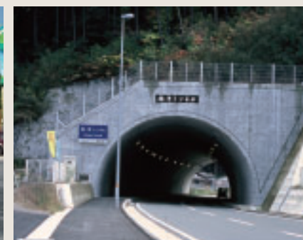
国道379号(内子町)の改良
