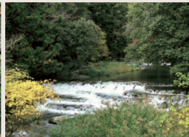
自然石の改修堰「正体下堰」(歴史的建造物の復元)
