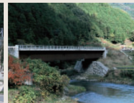
国道379号(小田町)新田橋(L=79.1m、W=12.0m)
