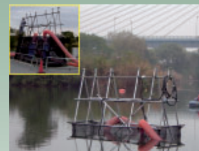
写真2 水中ポンプの設置状況
