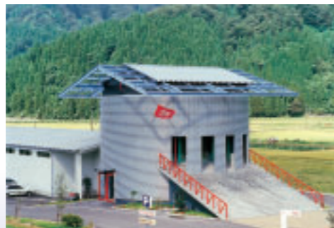
写真9 完成した工房
