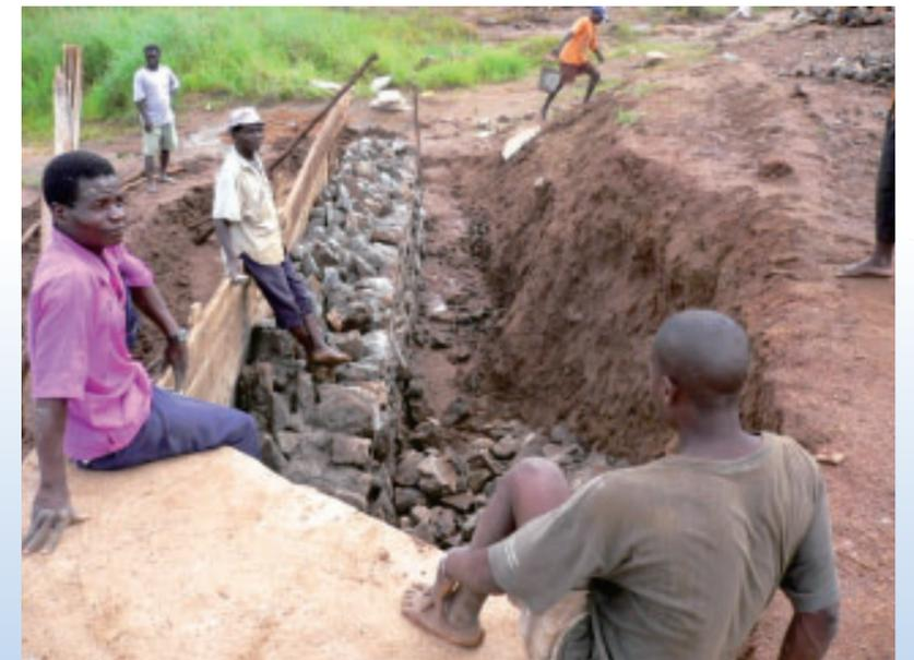
写真8 次の雨期に備えてカルバート新設中
