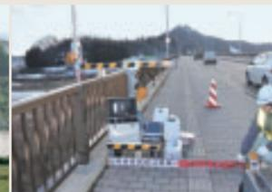
橋梁点検カメラシステム。橋面上での台車占有幅1.5m以下
