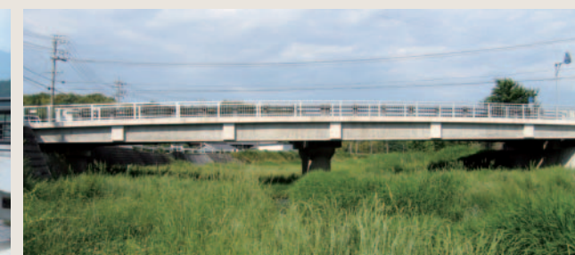
一級河川肱江川(猪飼橋歩道橋)(三重県桑名市)
