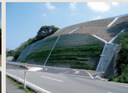
市道115号災害復旧(三重県いなべ市)
