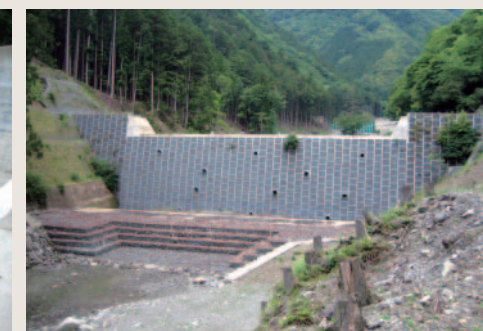
宮川水系古ヶ谷川(2号堰堤)(三重県多気郡大台町)
