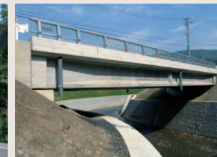
一級河川横輪川(上野橋)(三重県伊勢市)
