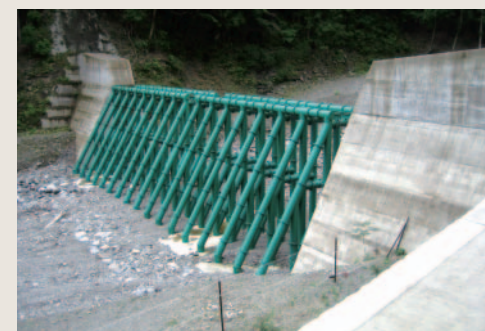
宮川水系古ヶ谷川(1号堰堤)(三重県多気郡大台町)
