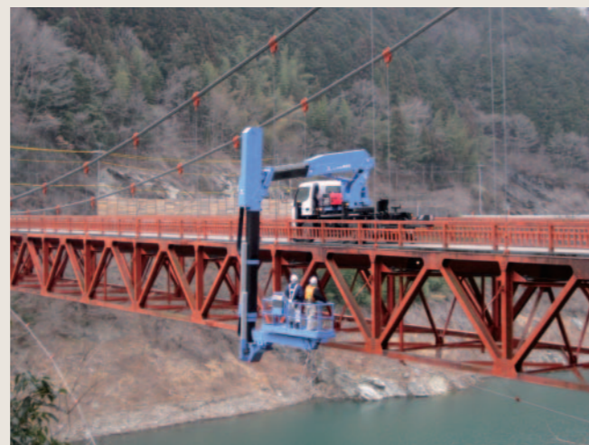
デッキトラス橋の点検
