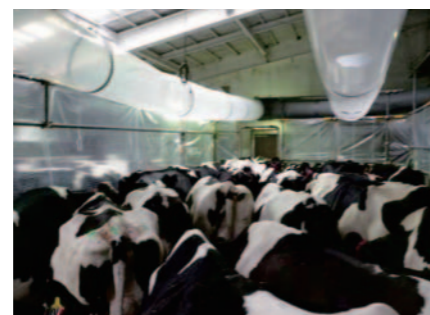
写真3 牛群待機室・冷房区(直接送風式)
