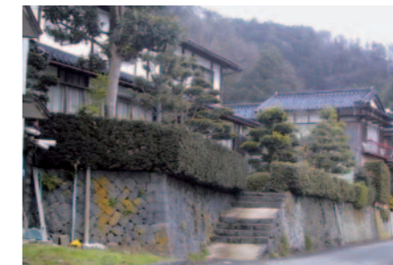
写真6 かつての豊岡盆地では山裾や高台に玄武岩で擁壁を築き生活の場とした
