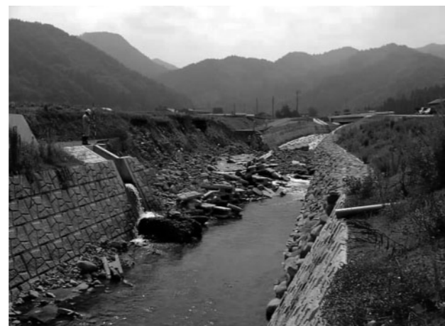
写真1 中小急流河川が改修後に再度被災した例
