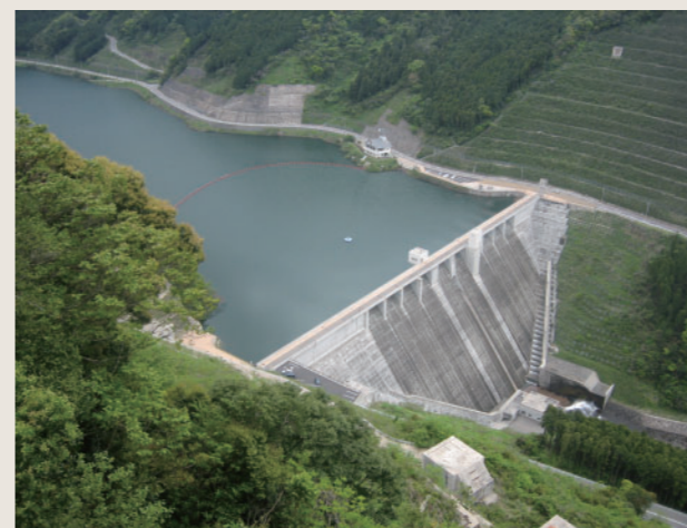
鹿島川水系中木庭ダム(佐賀県)
