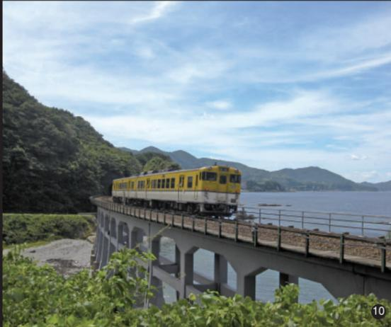
の被り厚を柱部80mm、桁部50mm、床版部40mmと標準の約2倍にしているほか、セメント量に対して1割珪酸白土を混入した。このことにより現在までのところ、表面に亀裂等が生じてはいるものの、内部の鉄筋の腐食はほとんど発生していないとのことである。とすれば、何事もマニュアルなどの標準に従っておけばよいと考えがちであるが、現場に即した対応が重要であることを改めて教えられる。
