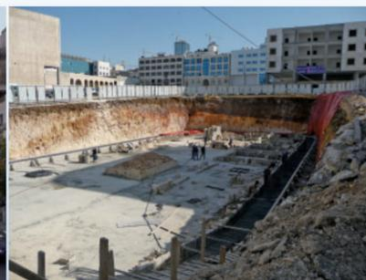
写真7 ビル工事の根伐りの状況
