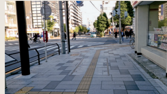
歩道改良(バリアフリー)工事
