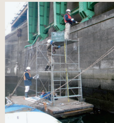
台船使用による点検
