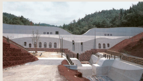
岐阜県「一の倉砂防ダム」
