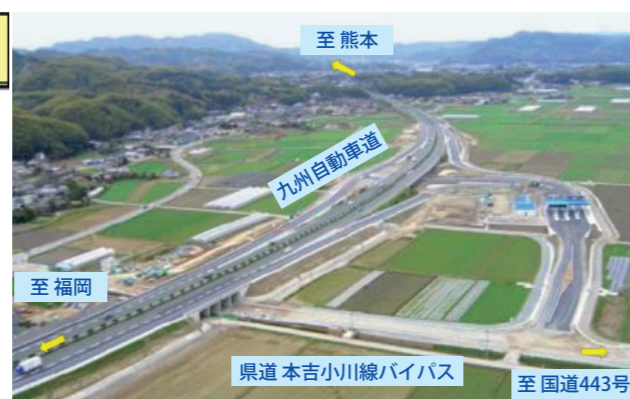
写真1 インター完成写真
