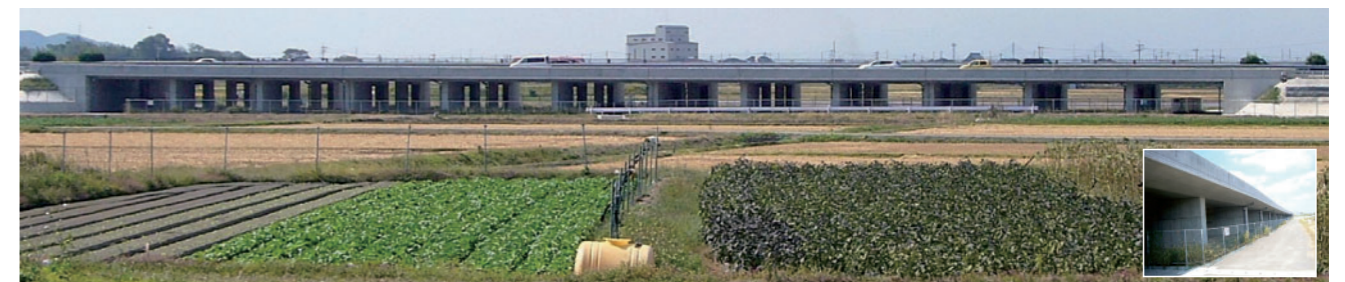
写真4 拡幅工事完成写真
