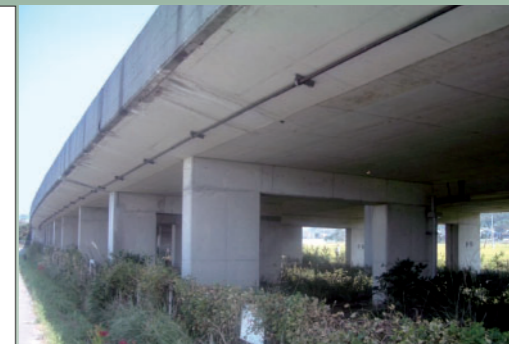
写真2 既設橋梁の状況
