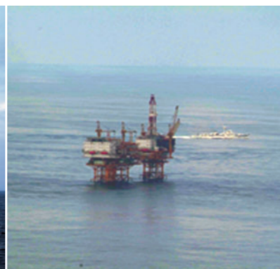
写真3 石油天然ガス海洋開発プラットフォーム
