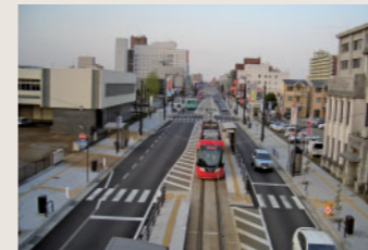
国道156号電線共同溝(高岡市)
