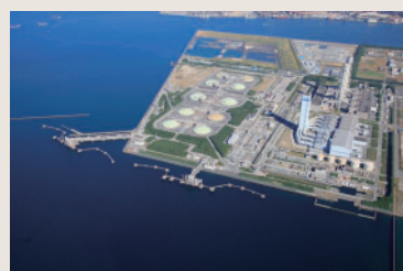
富津火力LNGバース(千葉県 木更津港)
